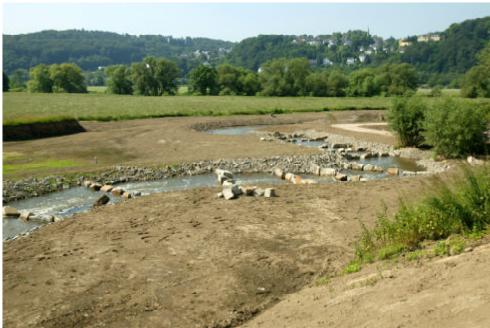
Bild 10: Fischweg nach Inbetriebnahme
