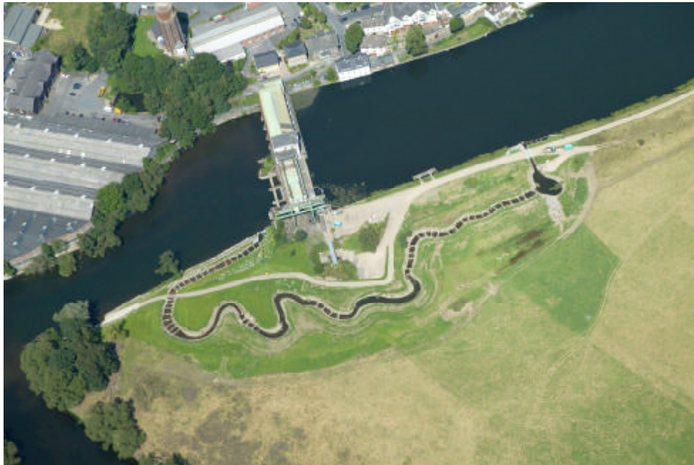
Bild 9: Ausleitungskraftwerk Wetter mit Fischweg
